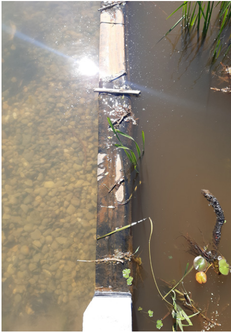
Az előülepitő (jobbra) a zavaros, oldott ásványokban gazdag víz pihentetését szolgálja, a tóba (balra) már a kevésbé zavaros víz jut (Fotó: Farkas Viktor Mátyás)
