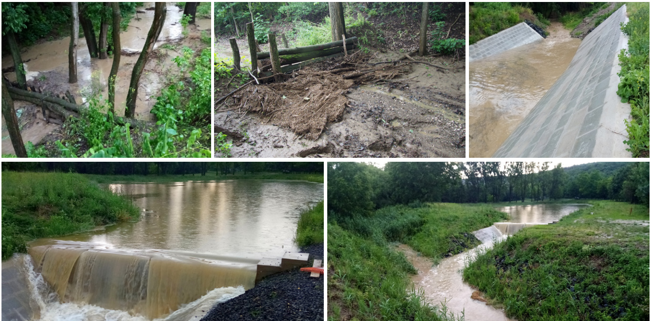
A rendszer működése villámárvízkor képekben: rönkgátak, felgyülemlt hordalék, belterületi iszapfogó és oldaltározó (Fotó: Tordai Sándor, forrás: Püspökszilágyi község honlapja: https://www.puspokszilagy.hu/ )
