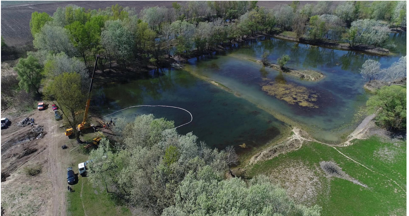
Cölöpverő gép a tanósvény stégjének építésénél; a kép bal szélén az új medret a régi tóval összekötő áteresz (Fotó: Filmever Stúdió)
